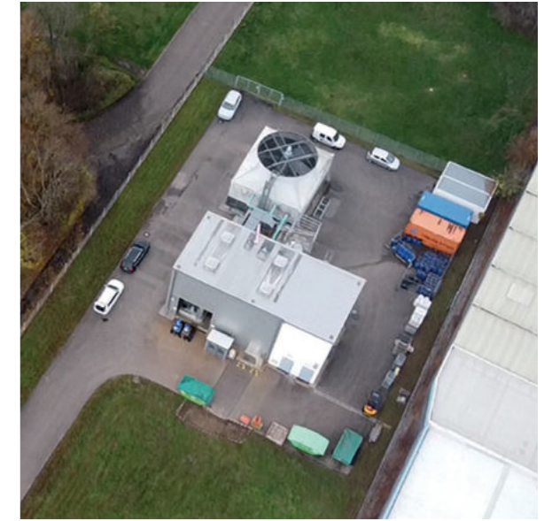
Flächenbedarf eines geothermischen Heizkraftwerks, hier: Anlage in Bruchsal © EnBW, Thomas Kölbl
