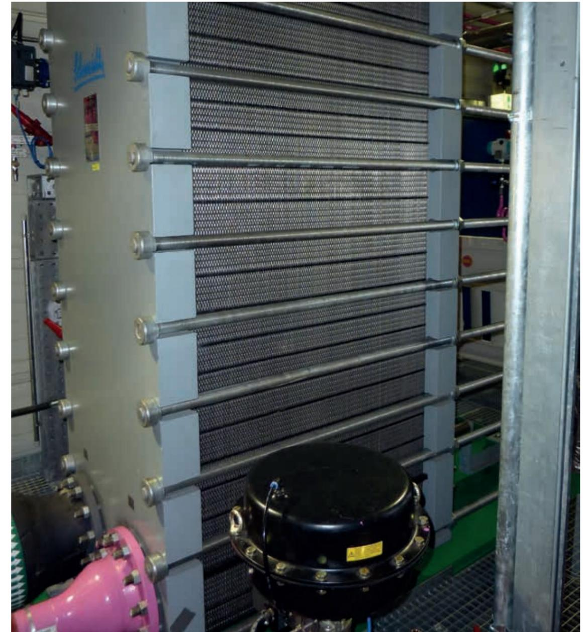
Plattenwärmetauscher © Stober
