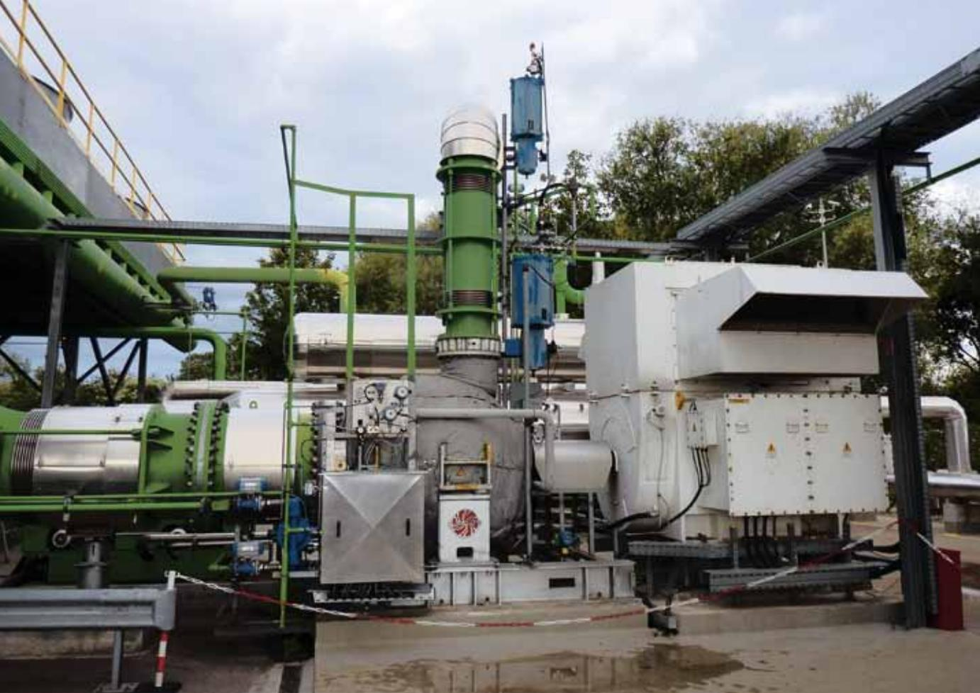
**Abb. 5.5:** Beispiel für eine ORC-Anlage, Geothermiekraftwerk Landau.
