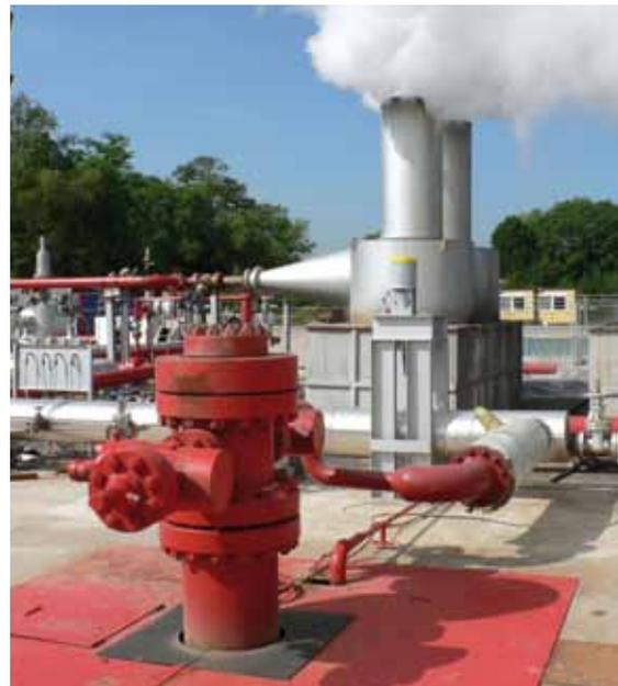
Hydrothermales Kraftwerk im Probetrieb. Im Vordergrund ein Preventer für die beiden Bohrungen und Abdampfschwaden während eines Pumpversuchs.
