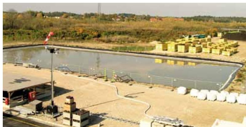
**Abb. 5.3:** Beispiel für ein Thermalwasserauffangbecken für hydraulische Tests, Geothermieanlage Kirchstockach, Bayern.
