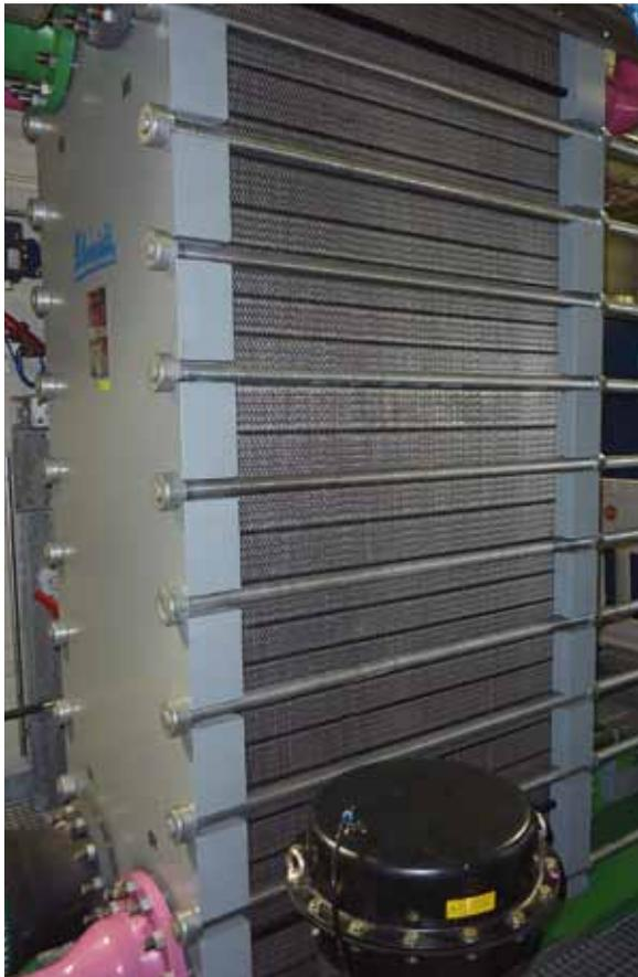
Abb. 1.2: Beispiel für einen Platten-Wärmetauscher.
